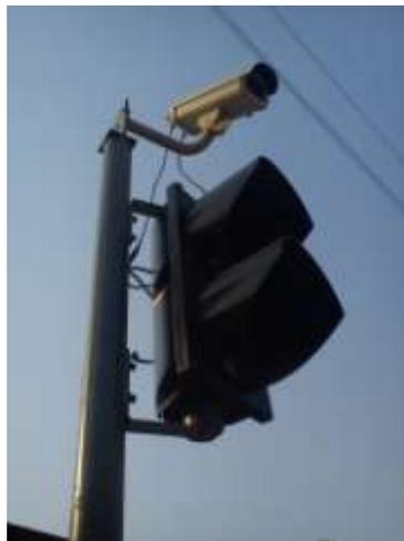
红绿灯由灯体和固定支架组成。红绿灯接线相对简单，由红灯控制线、绿灯控制线和地三芯组成，线路沿固定支柱下来，接入控制箱内。红绿灯安装尺寸如下图所示；
